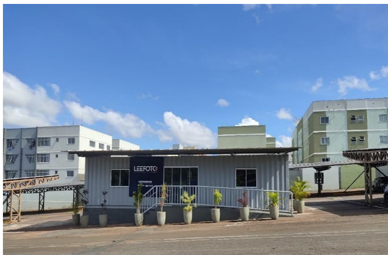
Figura 27 - Implantação do Laboratório de Eficiência Energética Fotovoltaica Fonte: CPA, 2021.
