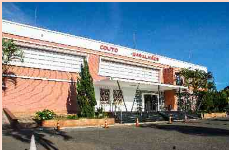
Fachada Colégio Couto Magalhães - Anápolis - dezembro/2017
